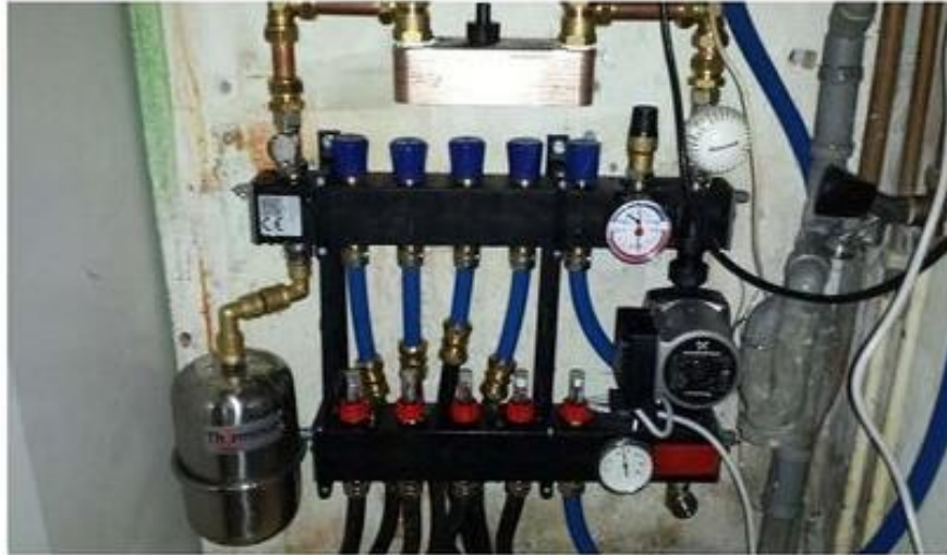
De nieuwe installatie
